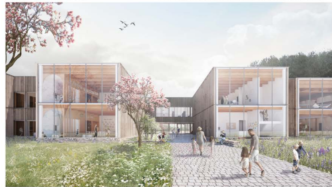
Vue depuis la rue: les façades vitrées des volumes marquent l'entrée de l'école et laissent entrevoir les activités qui s'y déroulent.
